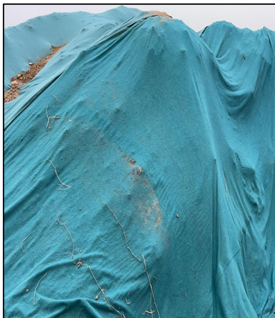
临时堆土覆盖
