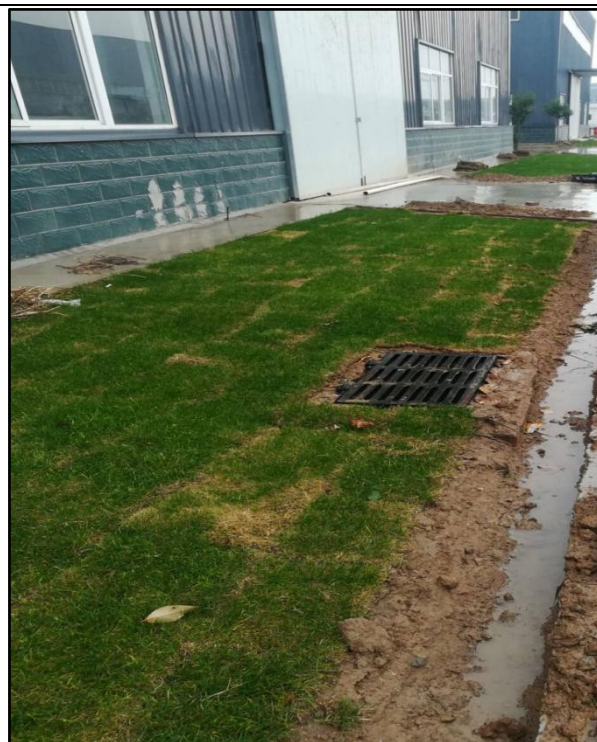
道路绿化区（铺草皮、雨水管网收集口）
