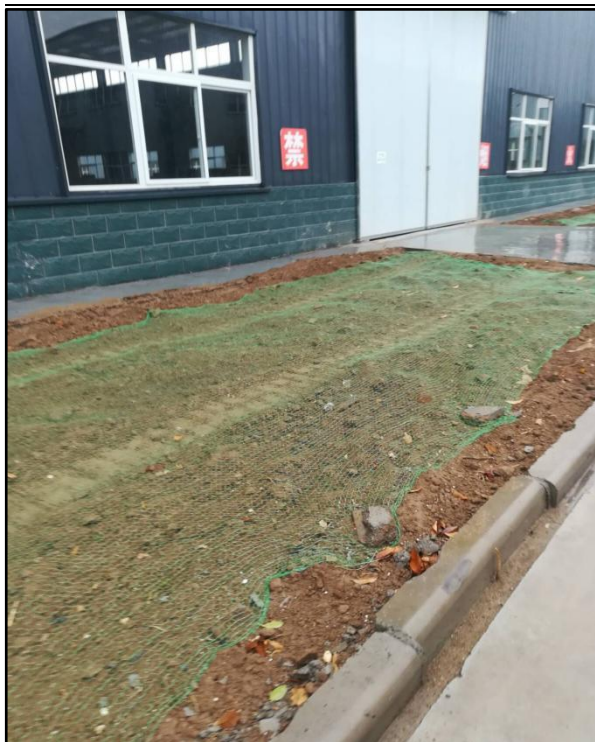
道路绿化区（临时覆盖）
