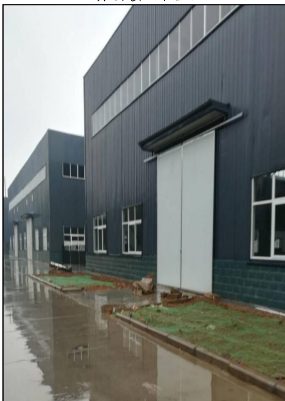
道路绿化区（临时覆盖）
