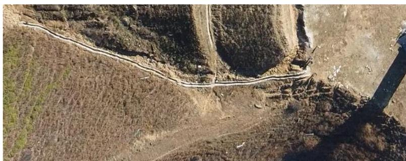
表土；电缆沟开挖少量余方就地在电缆沟施工范围内依地形平整，平整度应小于
